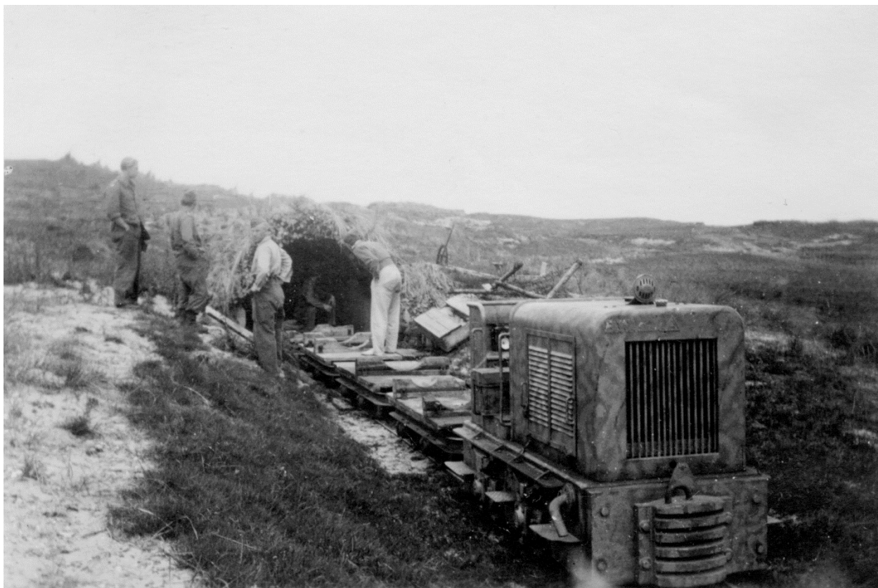
Dansk bygget lokomotiv af mærket BWD. Bygget af Pedershåb Maskinfabrik med dieselmotor på 6 cylindre fra B&W. Billedet er taget i Hanstholm under besættelsen. Foto: Museumscenter Hanstholm.
